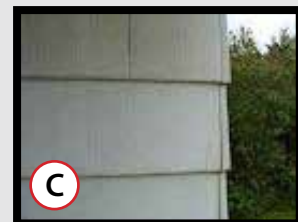
Asbestos Siding
