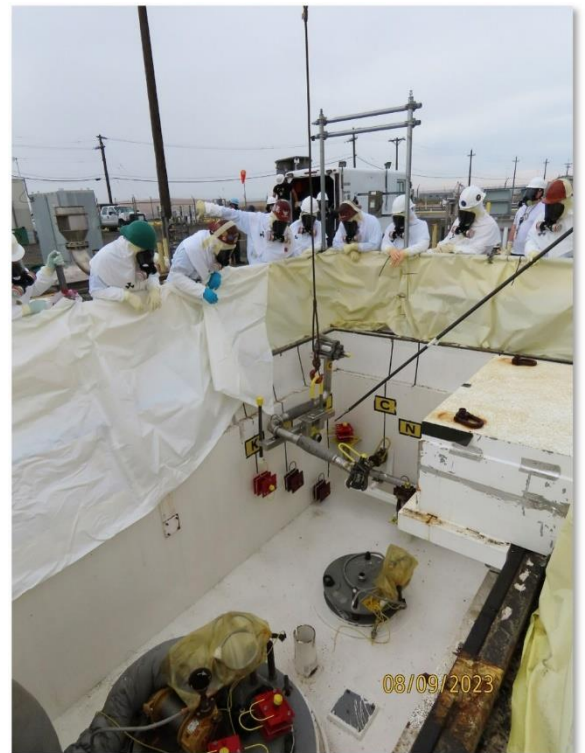
Trabajadores instalando línea de transferencia de residuos
